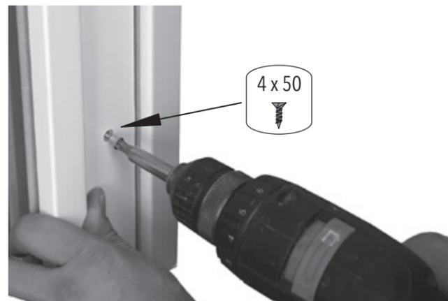
Vorbohren und verschrauben
