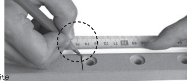
Schnitt immer hinter dem Lochrand, hier z.B. für Schiebetürkasten für fertige Stocklichte 70 cm
