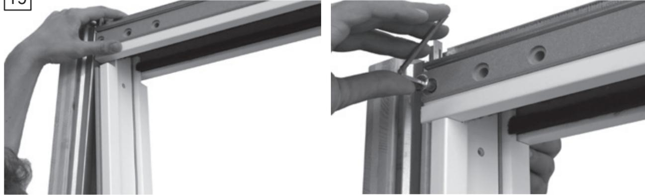
16 Anschlagprofil ins Lot setzen (eventuell unterfüttern) und mit dem Metallprofil verschrauben
